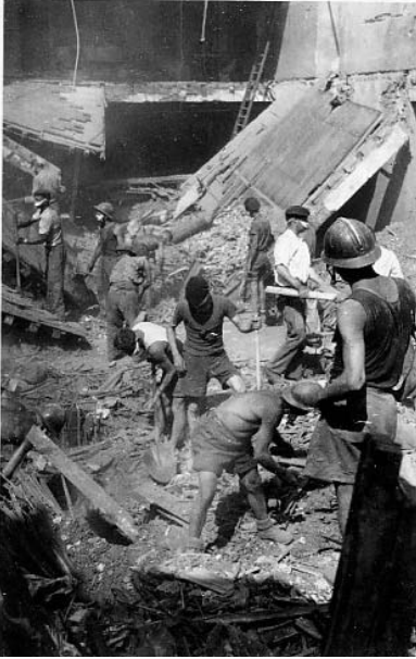
Les compagnons transformés en pompiers, terrassiers, déménageurs 16 août 1944.
